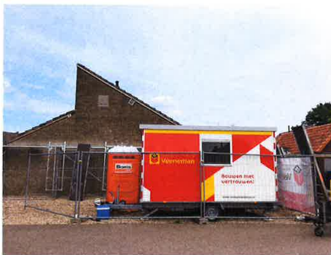
Werk in uitvoering in Hoenderloo
