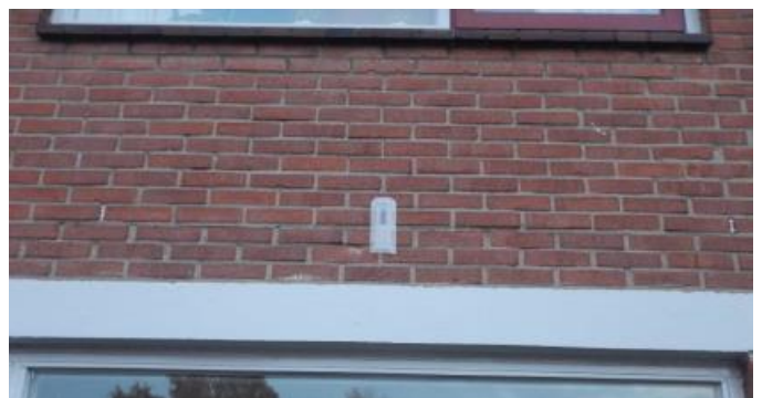
Voorbeeld dichtzetten open stootvoegen m.b.v. exclusion flap. (dit kan ook een houten kastje zijn)
