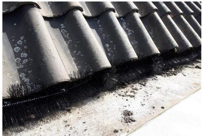
Voorbeeld afdichting goot d.m.v. gootborstels
