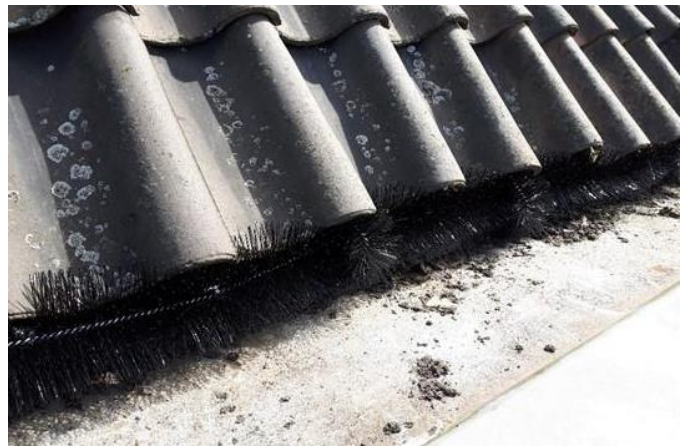
Voorbeeld afdichting goot d.m.v. gootborstels
