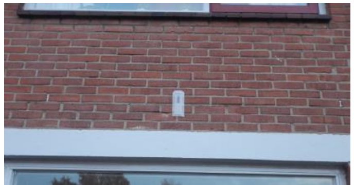
Voorbeeld dichtzetten open stootvoegen m.b.v. exclusion flap
