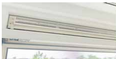
Ventilatie toevoer rooster
