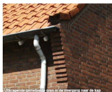
Uitragende gevels en oren in de overgang naar de kap
