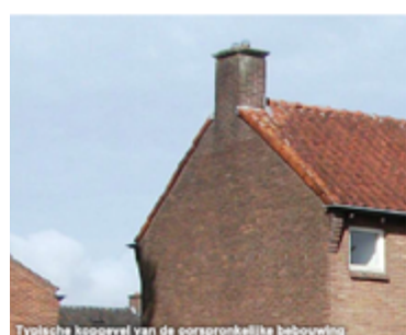
Typische kopgevel van de oorspronkelijke bebouwing
